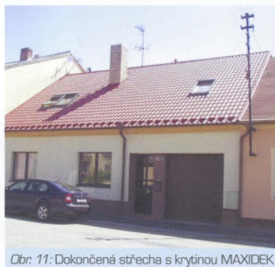
Obr. 11: Dokončená střecha s krytinou MAXIDEK
