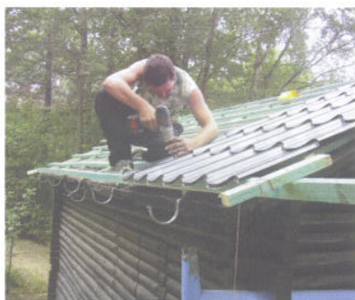
Obr. 8: Montáž krytiny MAXIDEK na latě
