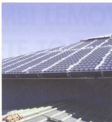
Obr. 10: Střecha před dokončením
