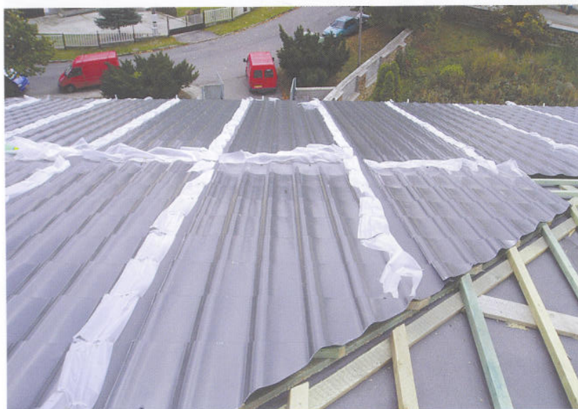
Obr. 1: Krytina MAXIDEK pokládána na latě – v překrytí odstraněná fólie
