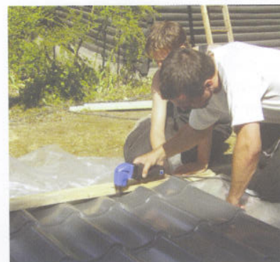
Obr. 7: Úprava délky tabule prostřihovačem (používání úhlové brusky, kotoučové pily a přímočaré pily je zakázáno)
