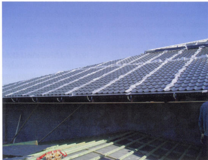
Obr. 8: Střecha před dokončením
