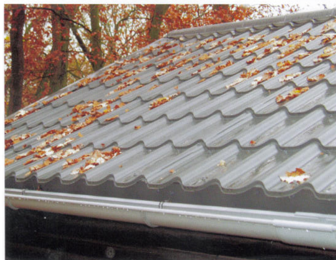
Obr. 9: Dokončená střecha s krytinou MAXIDEK
