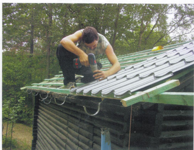
Obr. 6: Montáž krytiny MAXIDEK na latě
