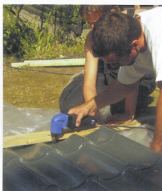
Obr. 4: Úprava tabule prostřihovačem
