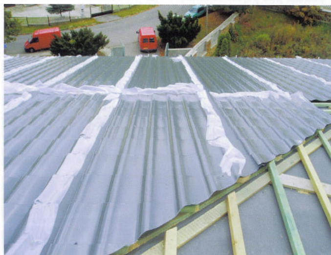
Obr. 5: Krytina MAXIDEK pokládána na latě – v překrytí odstraněná fólie
